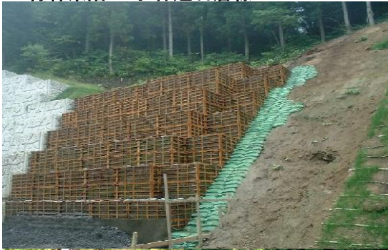
L=6.95m H=7.5m W=1.0m ・水の通りに設置し、洗掘防止
