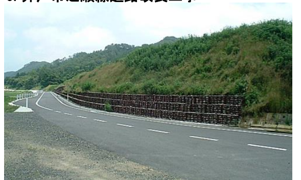
L=185m H=2m W=1m 370㎡ ・大幅な工期短縮により、トータルコストを削減
