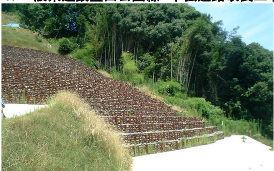
L=185m H=2m W=1m 370㎡ ・透水性 背面の水分を流す
