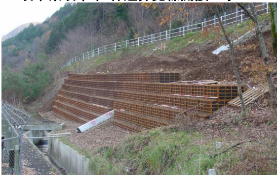
L=30m H=4.0m W=1.0m 130.5㎡ ・植生シートと併用することで現地発生土を使用可能
