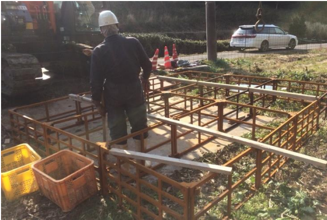
陸上で組立て、バックホウで吊り、施工。
