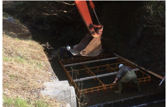
陸上で組立て、バックホウで吊り、施工。
