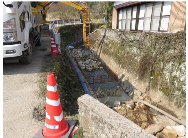
中詰石の投入
